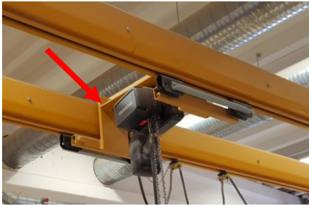
Figur 6-3. Höjning av lyftanordningen på traversen.
